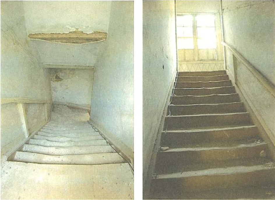
Εικ. 9, 10. Απόψεις των δύο σκελών της ξύλινης κλίμακας που οδηγεί στην γ' στάθμη του κτιρίου.
