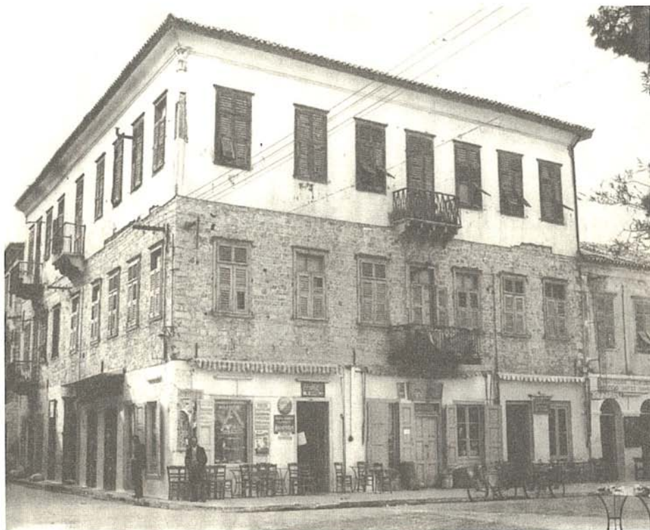
Εικ. 15. Φωτογραφία του κτιρίου του 1957. Διακρίνονται πολλά αρχικά στοιχεία της κατασκευής, καθώς και απουσία του κοσμητή του Β' ορόφου.
