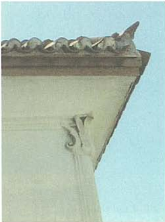
Εικ. 12, 13. Άποψη του εσωτερικού και του εξωτερικού της στέγης αντίστοιχα. Κάτω: Εικ. 14. Λεπτομέρεια του περιμετρικού γείσου και των γωνιακών παραστάδων.
